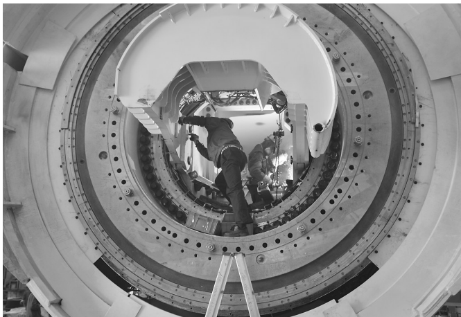
工人们正在加紧组装盾构机
